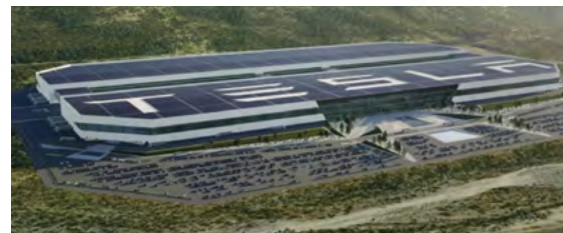
Gigafactory Mexico, Tesla. Santa Catarina, Nuevo León.
