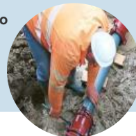
Mantenimiento y Reparación
